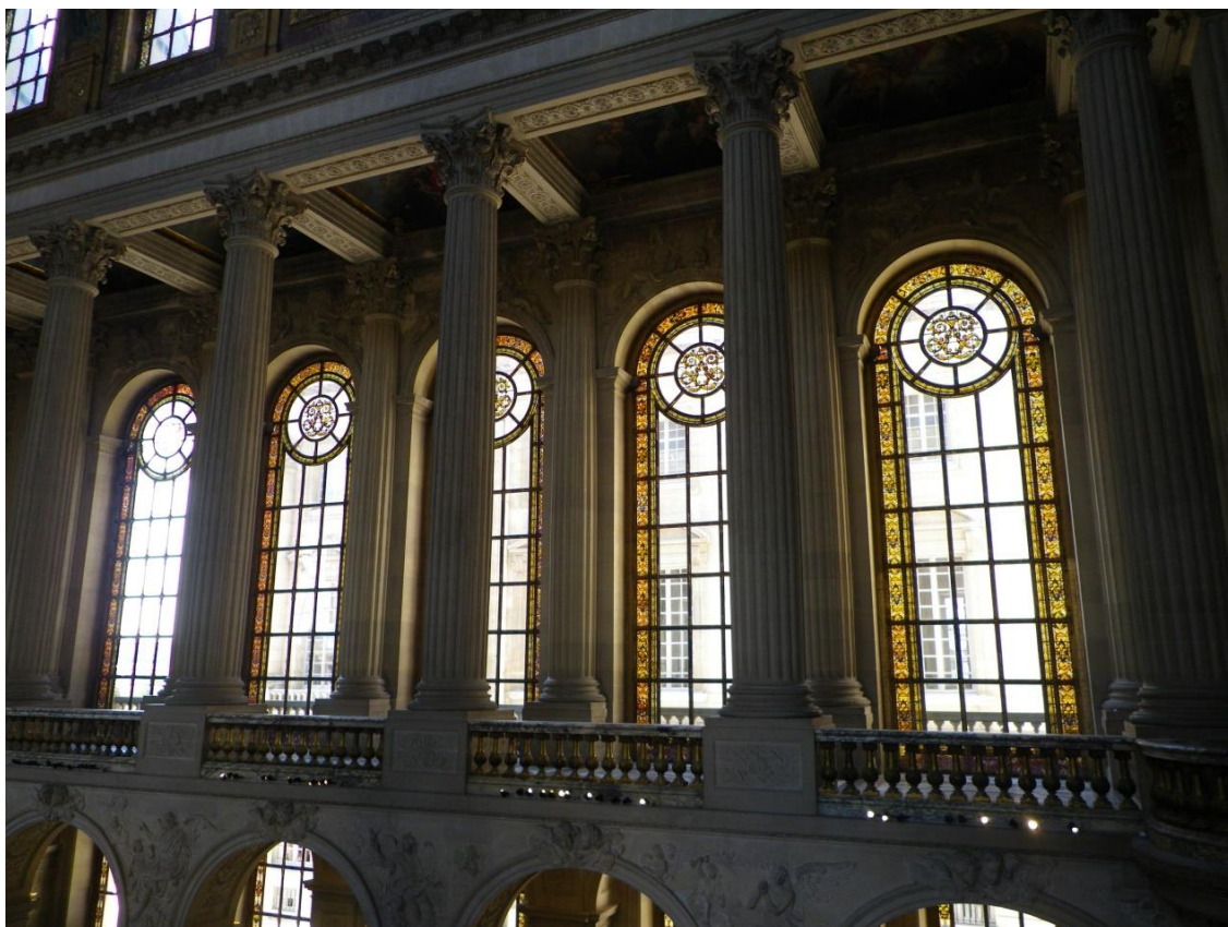
Fig. 1. Vue intérieure des vitraux de la chapelle royale de Versailles avant la restauration. Chaque verrière est composée de grandes glaces incolores et d'une bordure de panneau en verre mis en plomb. © Claudine Loisel, 2015.
